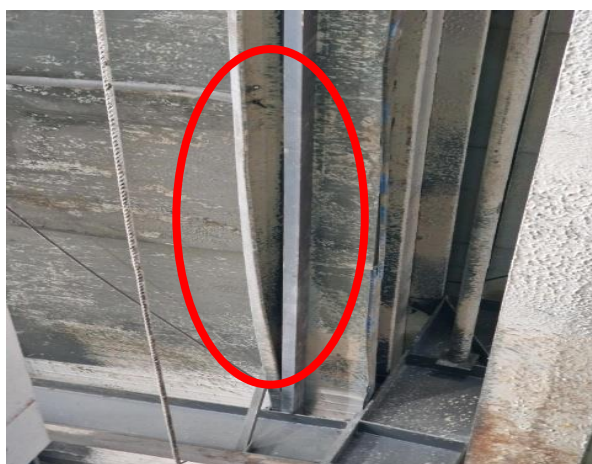
Аюулыг устгах ажил хийгдэж байна. Ачаалал даахгүй нумарч эргэсэн С төмөр болон нэмэлтээр хажууд нь хийсэн С төмрийн харагдах байдал
