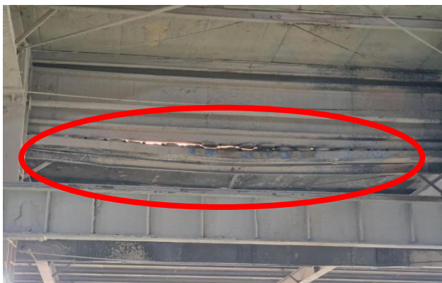
Аюулыг устгах ажил хийгдэж байна. Ачаалал даахгүй нумарч эргэсэн С төмөр болон нэмэлтээр хажууд нь хийсэн С төмрийн харагдах байдал
